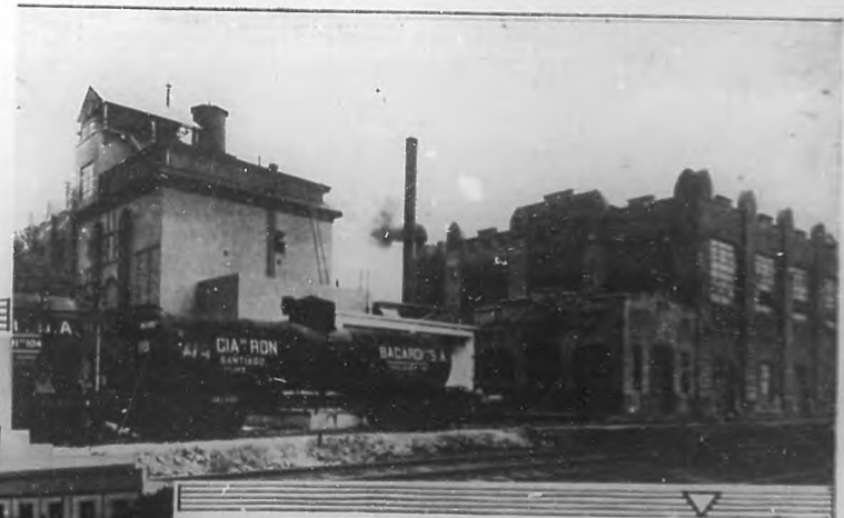
Aspecto general de los edificios que componen la fábrica del "Ron Bacardi", considerada como una de las principales industrias de Cuba.
